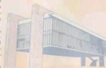
Foto do edifício do Consulado Geral do Brasil em Nova York.
